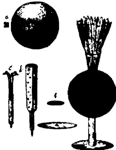
Abb. 84. Handgranate mit Fallzündung.
